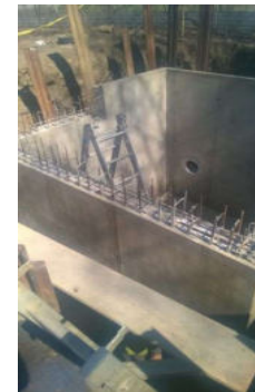
Tolózár akna kivitelezése
