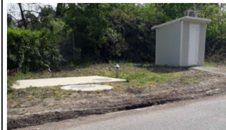
A központi vízelosztó - a földbe süllyesztett ún. tolózár akna - és mérő konténer
