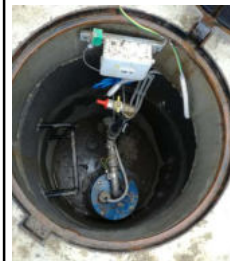
Kútakna szerelvényekkel
