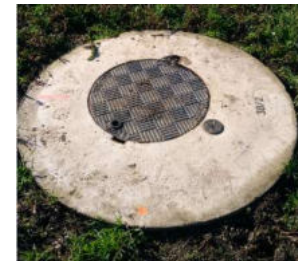
Kútakna zárt állapotban
